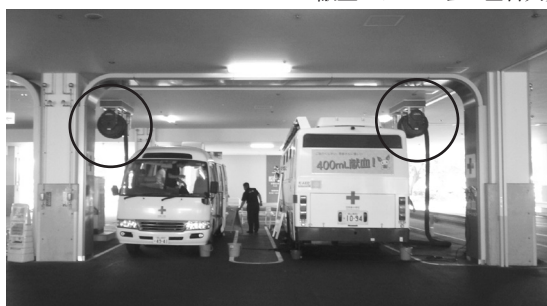
献血ステーション左右天井に「献血専用排気システム」
