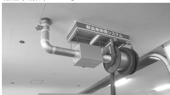
献血ステーション左右天井に「献血専用排気システム」
