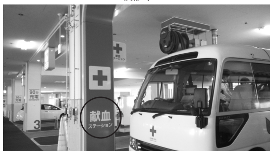
献血ステーション左右天井に「献血専用排気システム」
