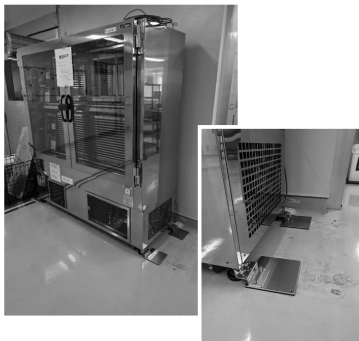
図2 血小板振とう機の地震対策
